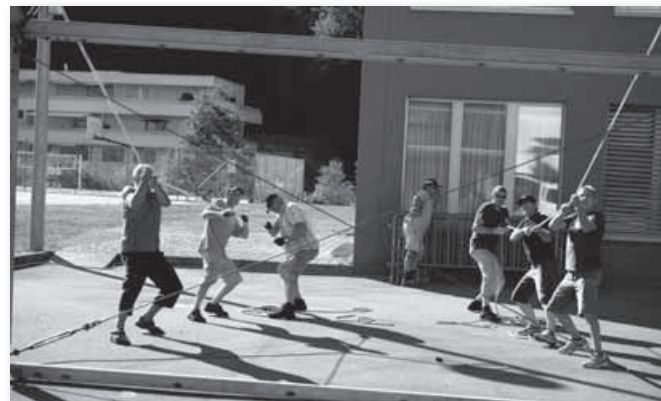
Der Aufbau kostet Kraft.
