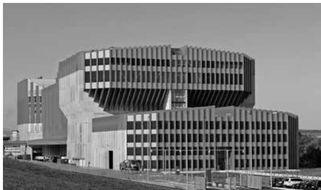
Vorbildliche Energieeffizienz: die Renergia in Perlen
