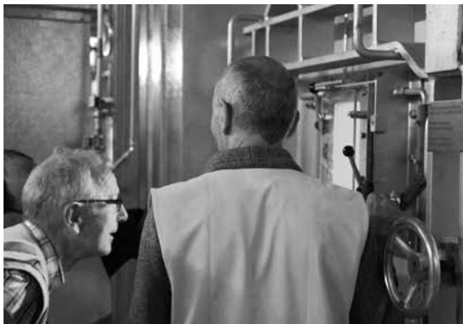
Blick in den Verbrennungsofen
